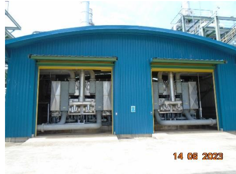
ภาพที่ 2-10 วัสดุปิดครอบแหล่งกำเนิดที่มีเสียงดัง
