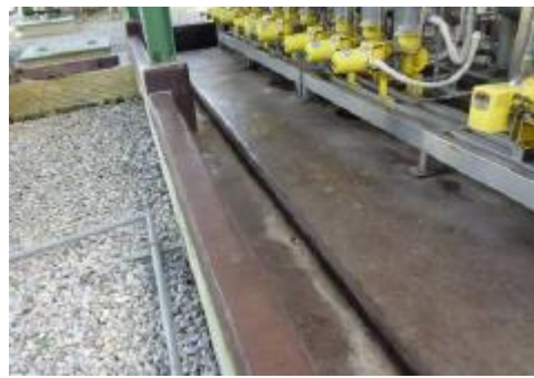
ภาพที่ 2-12 รางระบายน้ำฝนที่อาจปนเปื้อน
