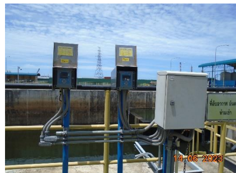
ภาพที่ 2-16 ระบบตรวจวัดน้ำทิ้งแบบอัตโนมัติ
